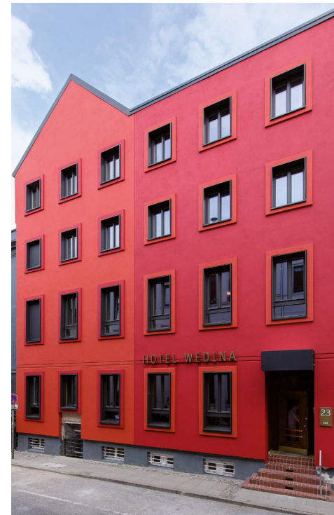
Fassade des roten Hauses
