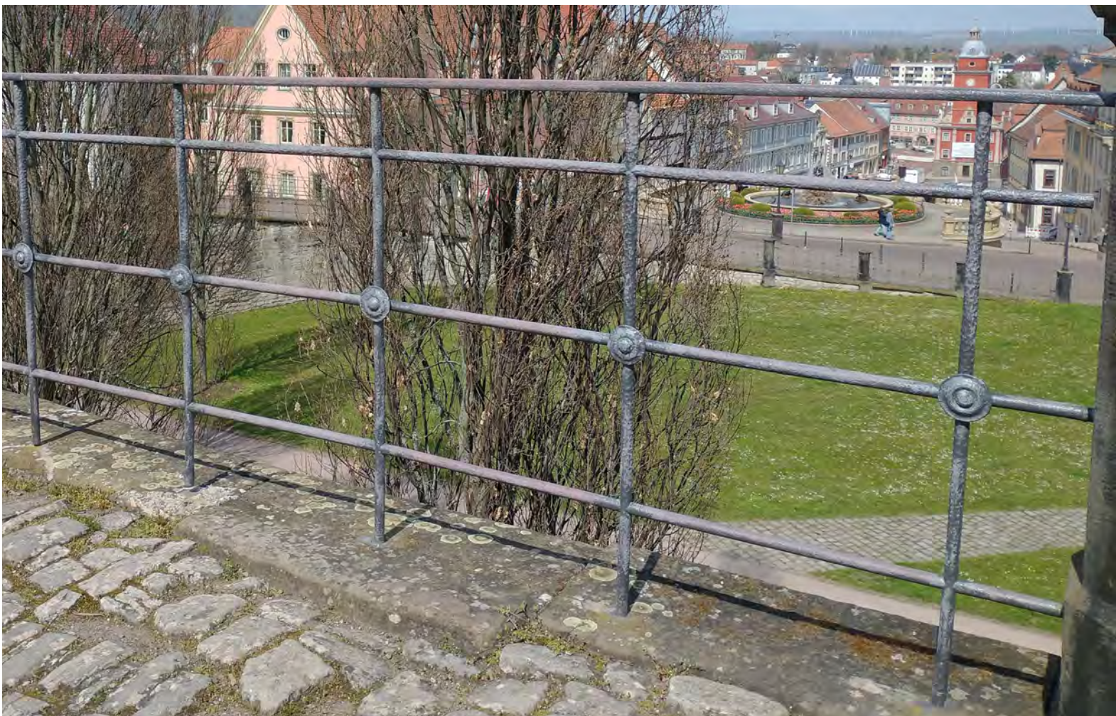
Geländer Satelit umschließend
