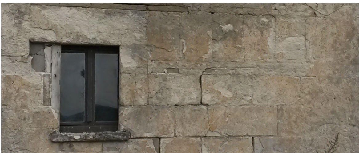
Abb. 35 Detail Seitenflügel mit Mauerwerk aus Betonsteinen
