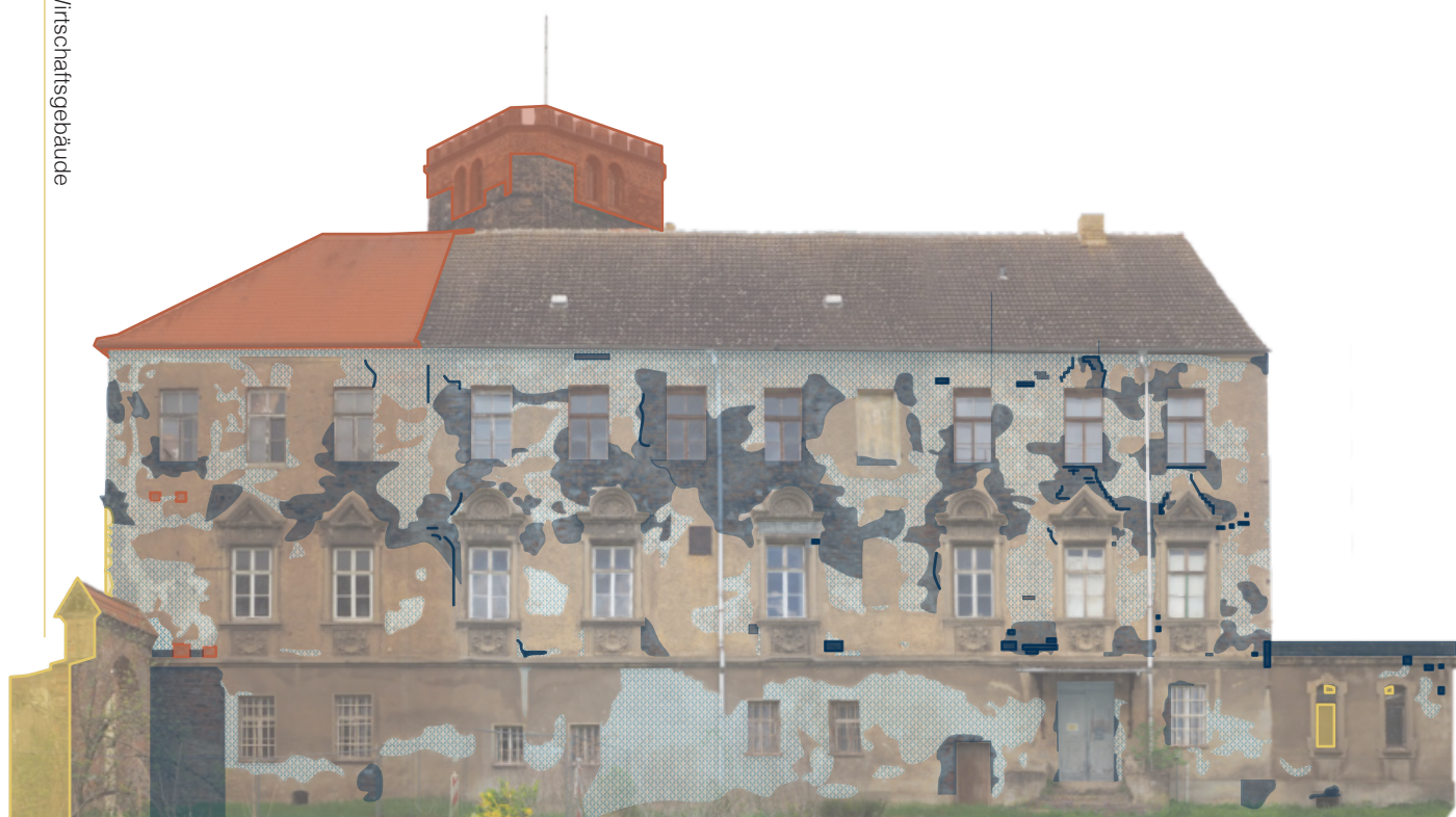
Abb. 124. Schadenskartierung Ansicht Ost
