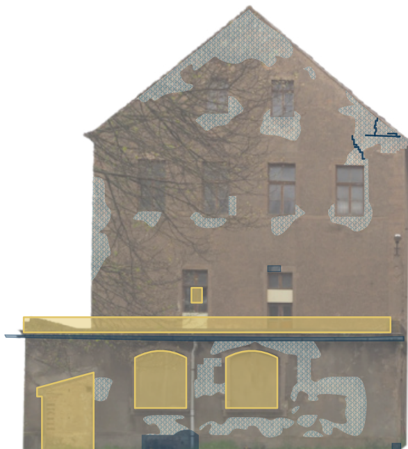
Abb. 127. Schadenskartierung Ansicht Nord Ostflügel
