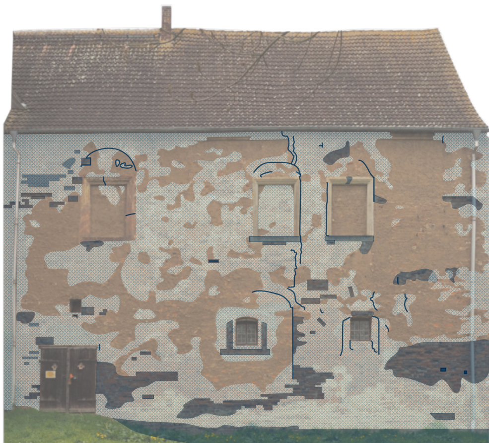
Abb. 130. Schadenskartierung Teilansicht West Westflügel
