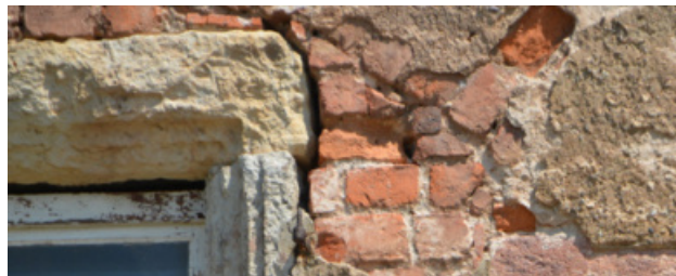
Abb. 141. Foto Detail Fenstergewand Sandstein
