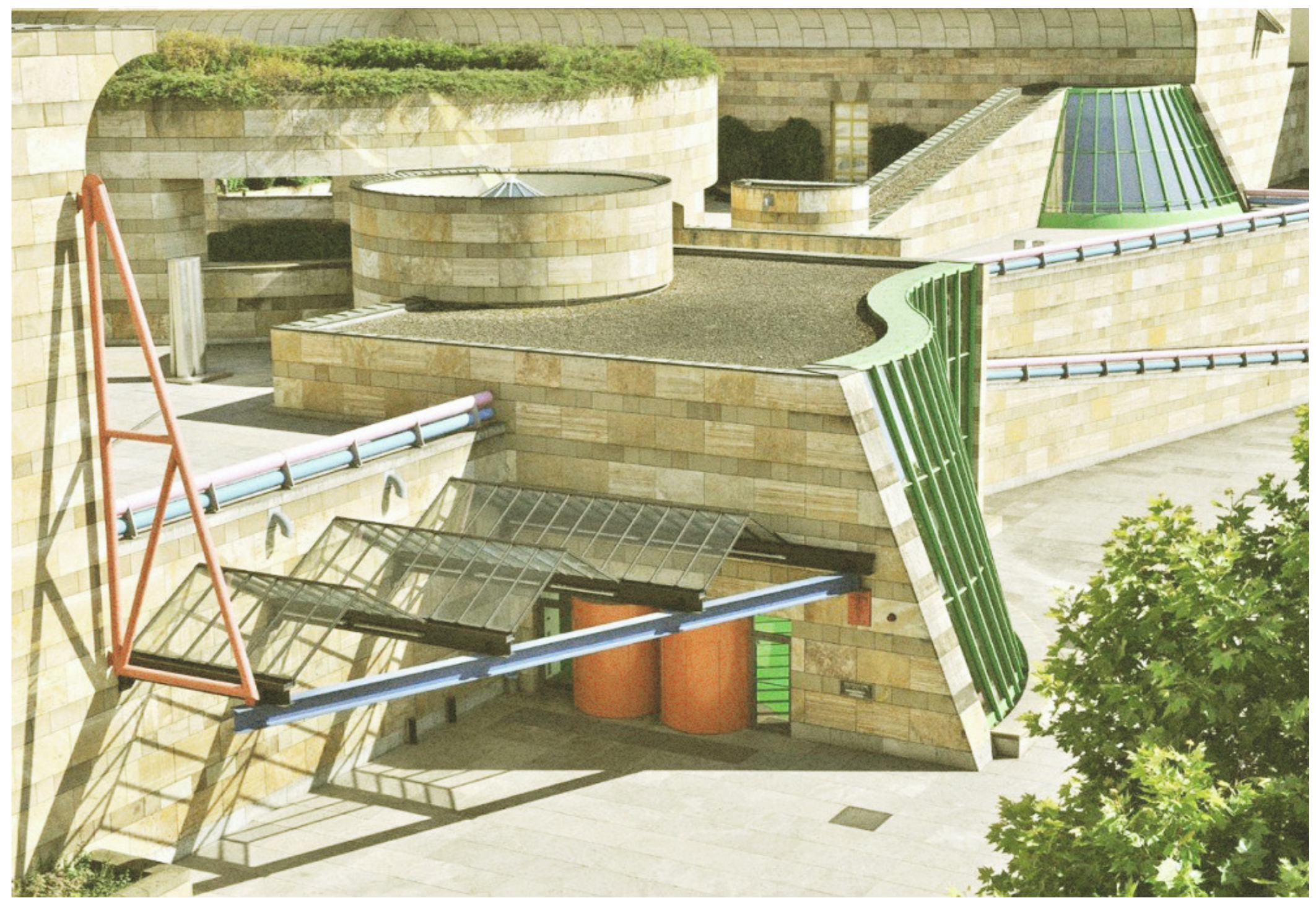
Abb.1 James Stirling, Neue Staatsgalerie Stuttgart, 1979-84, Hauptfassade
