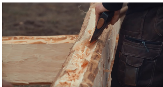
Abb. 5: Bearbeitung mit Handaxt für die nächste Balkenlage
