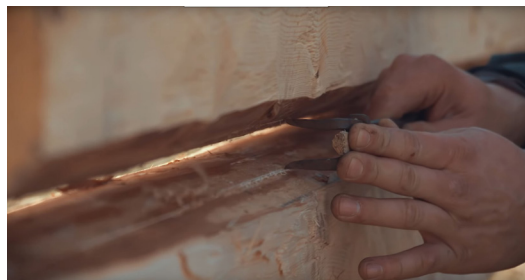
Abb. 4: Übertragung der Stammkontur mit speziellem Zirkel
