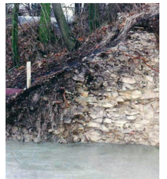
Abb. 74 a,b: Schnitt durch den östlichen Wall, nach 1990: Oben intakte Erdschichten, unten die abgerutschte Wallböschung
