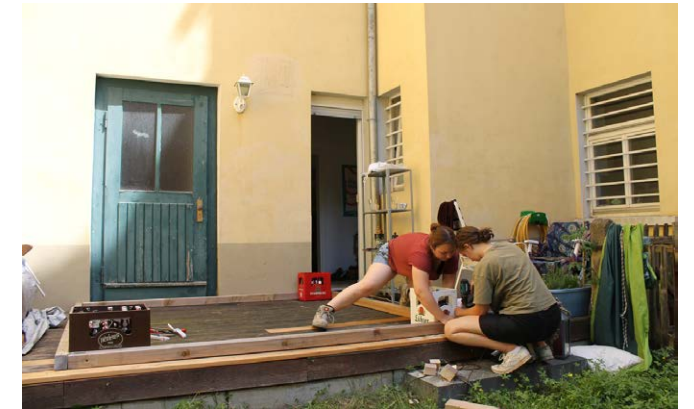
RECHTE WINKEL NACH DEM BIERKASTENSYSTEM - VERSCHRAUBEN
