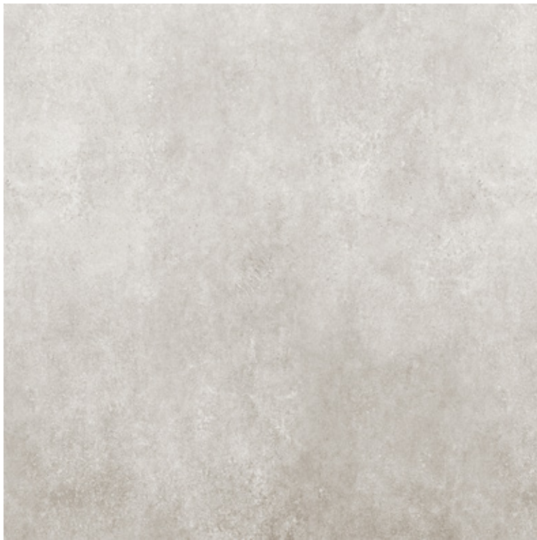
Neubau Konstruktion Beton
