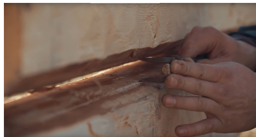
Abb. 4: Übertragung der Stammkontur mit speziellem Zirkel
