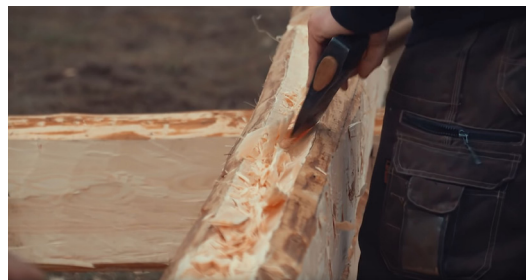
Abb. 5: Bearbeitung mit Handaxt für die nächste Balkenlage
