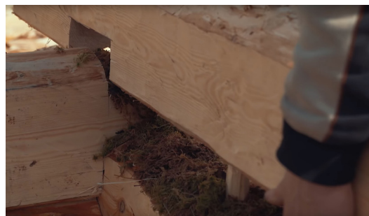
Abb. 6: Moos zwischen den Balkenlagen
