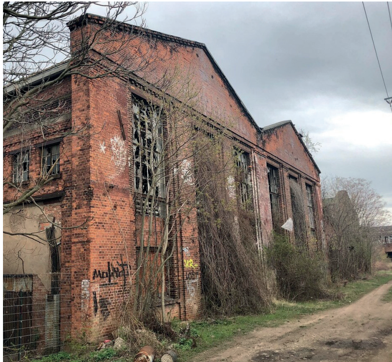
Hallenkomplex West (Süden)
