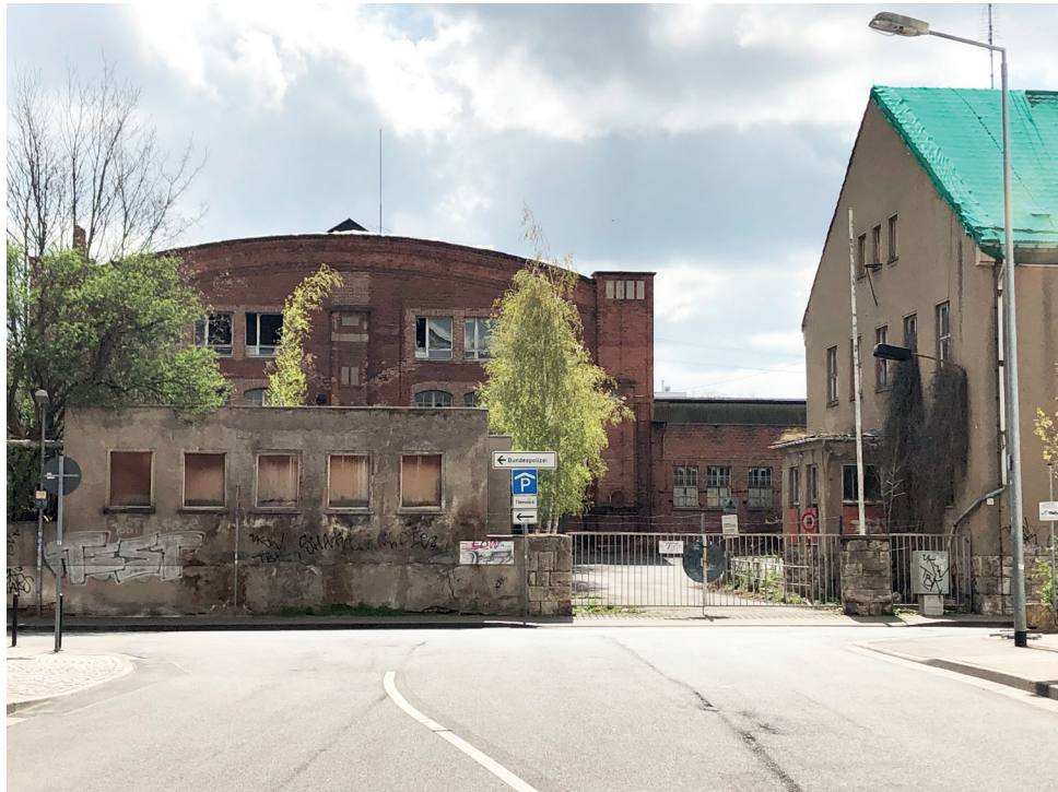
Hallenkomplex Ost (Norden)
