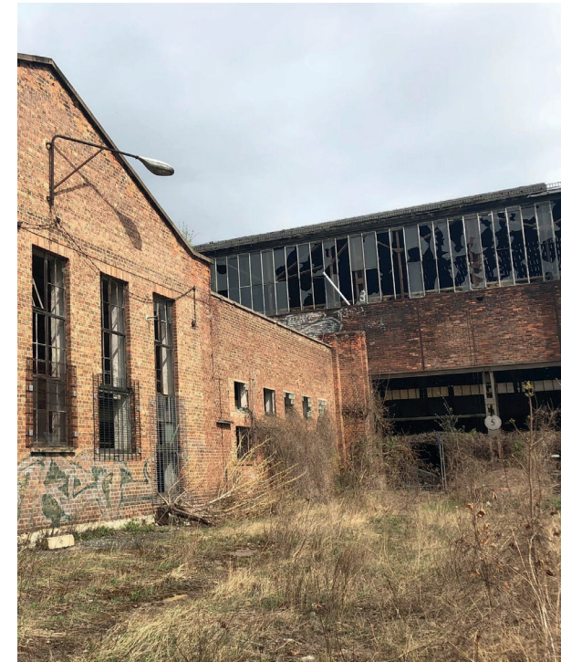
Ehem. Gleisanschluss (Süden)
