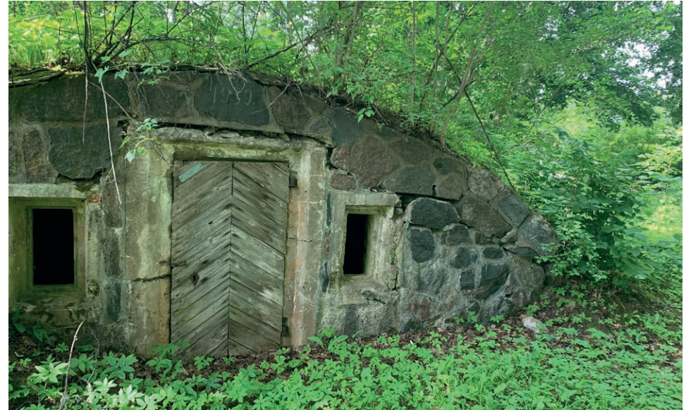
„Bunker“ bzw. Kellergebäude, rechts neben Holzschuppen
