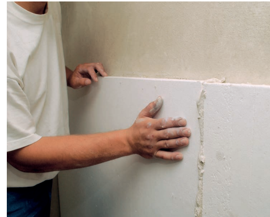
Innendämmung Kalziumsilikatplatten
