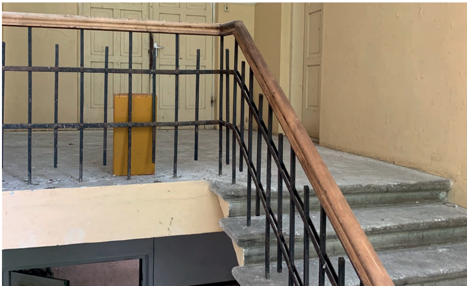
Original 1936 | Treppengeländer und Betontreppe
