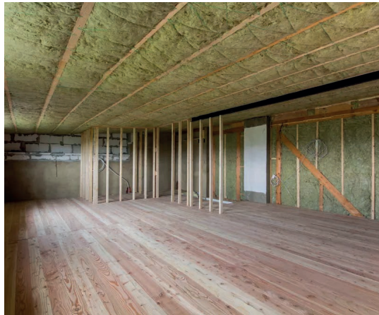
Holzständerwand Innendämmung
