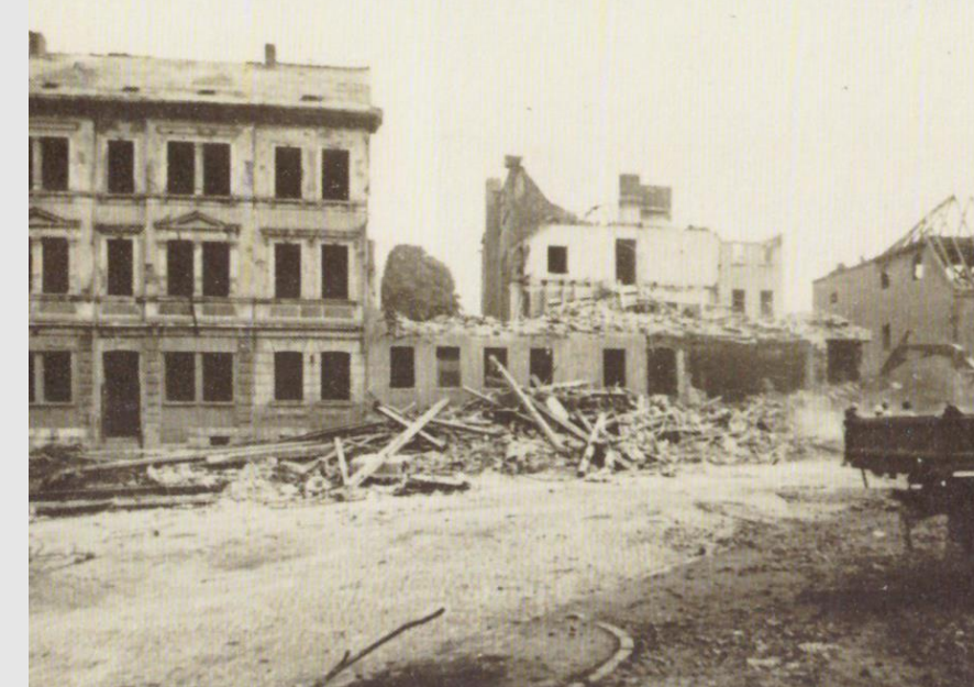
Abb. 5: Abbruch von Altbauten für den Bau des Langen Jakob 1970 (Bodenschatz 2016: 38)
