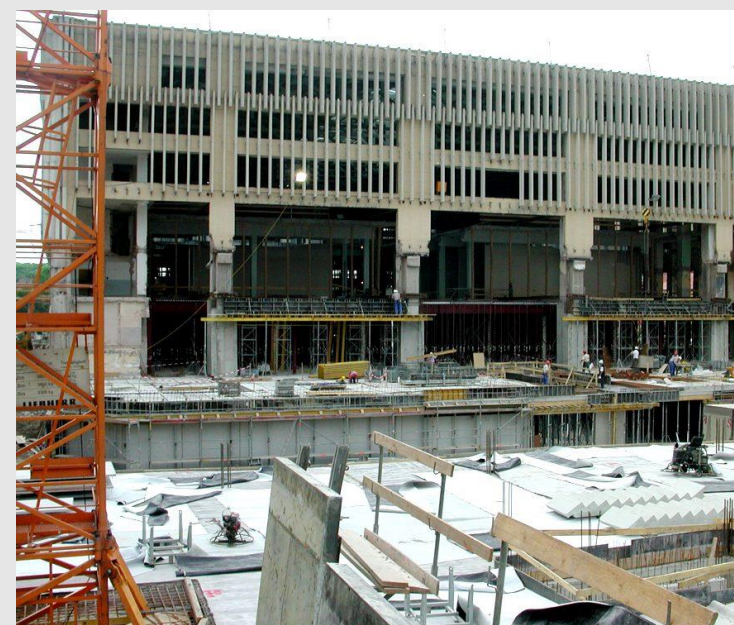
Abb. 4: Umbau der Mehrzweckhalle zum Atrium in 2005 (Bauhaus-Universität 2015)
