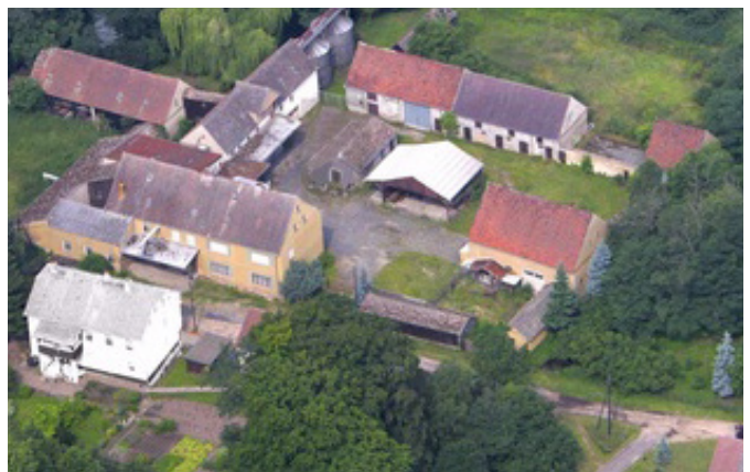
ABB. 22: Luftbild, Alte Mühle
