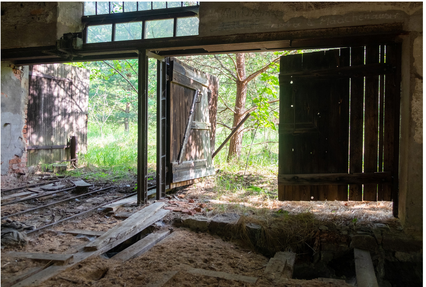
ABB. 12: Altes Sägewerk, Zustand heute
