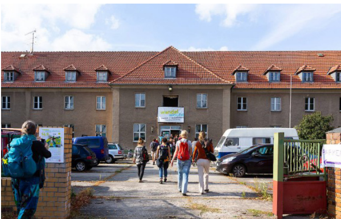
ABB. 21: Eingangstor, Haus des Wandels
