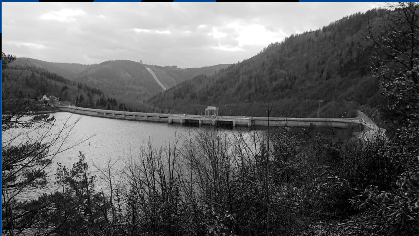
Abb. : Blick über die Staumauer Hohenwarte I zu Hohenwarte II/ Liere 2022
