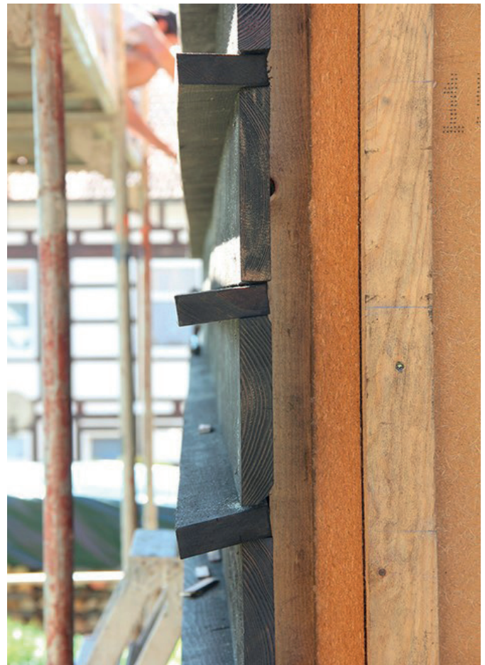
ABB. 33: Fassadenholz und Unterkonstruktion
