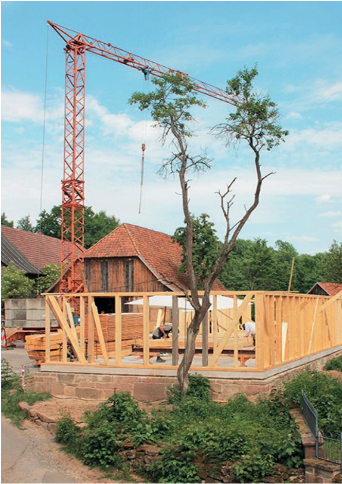
ABB. 24: Holzrahmenkonstruktion im Erdgeschoss
