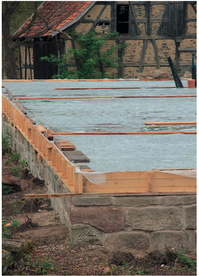
ABB. 21: geschützte Bodenplatte
