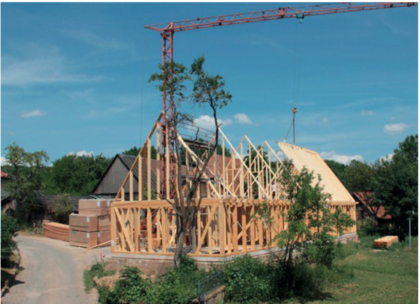
ABB. 26: Verlegung der Dachsparren
