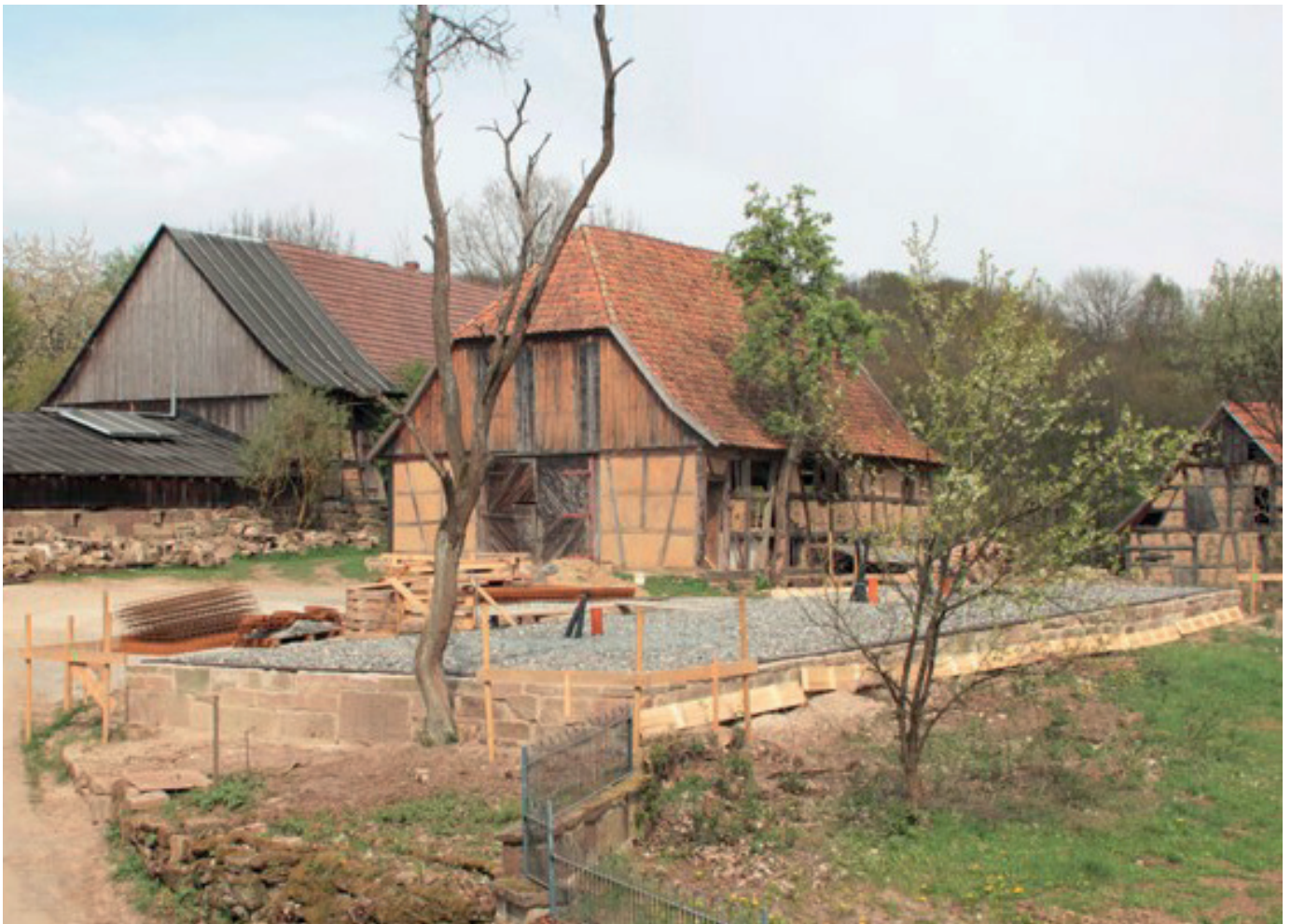
ABB. 19: Grundmauer Baubecken mit Glasschaumschotter
