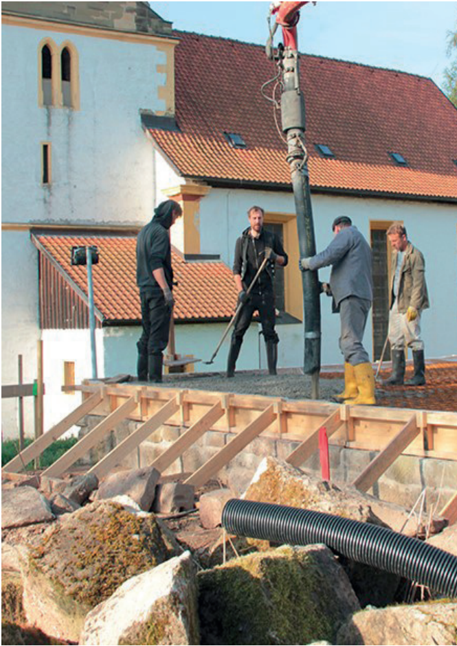
ABB. 20: Beton in Holzschalung gießen
