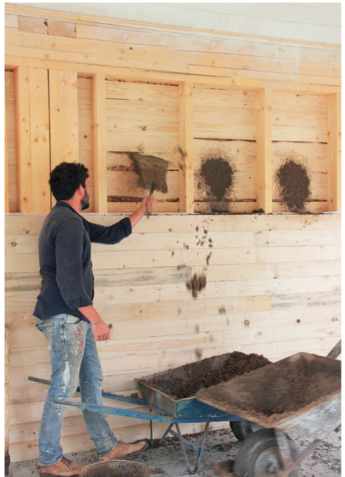
ABB. 27: Liapor-Lehm-Füllung in Holzrahmenkonstruktion
