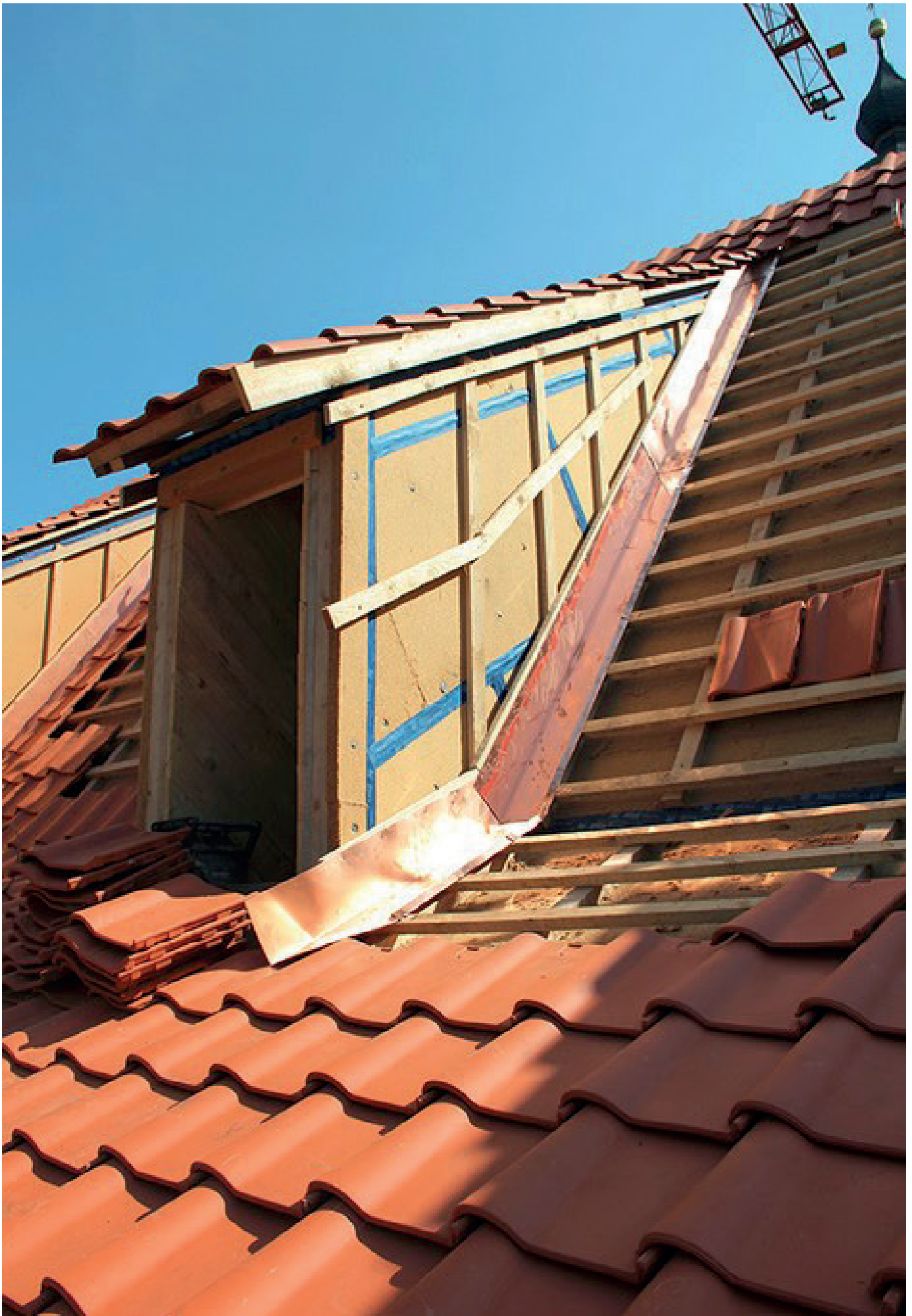
ABB. 32: Dachaufbau an einer Gaube
