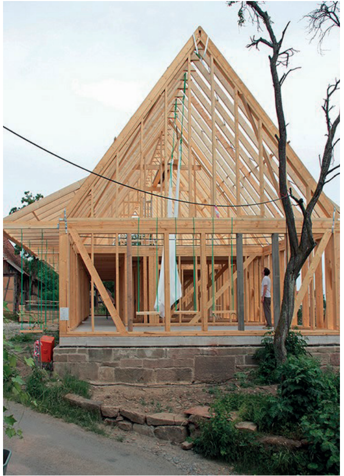
ABB. 25: Holzrahmenkonstruktion EG und DG
