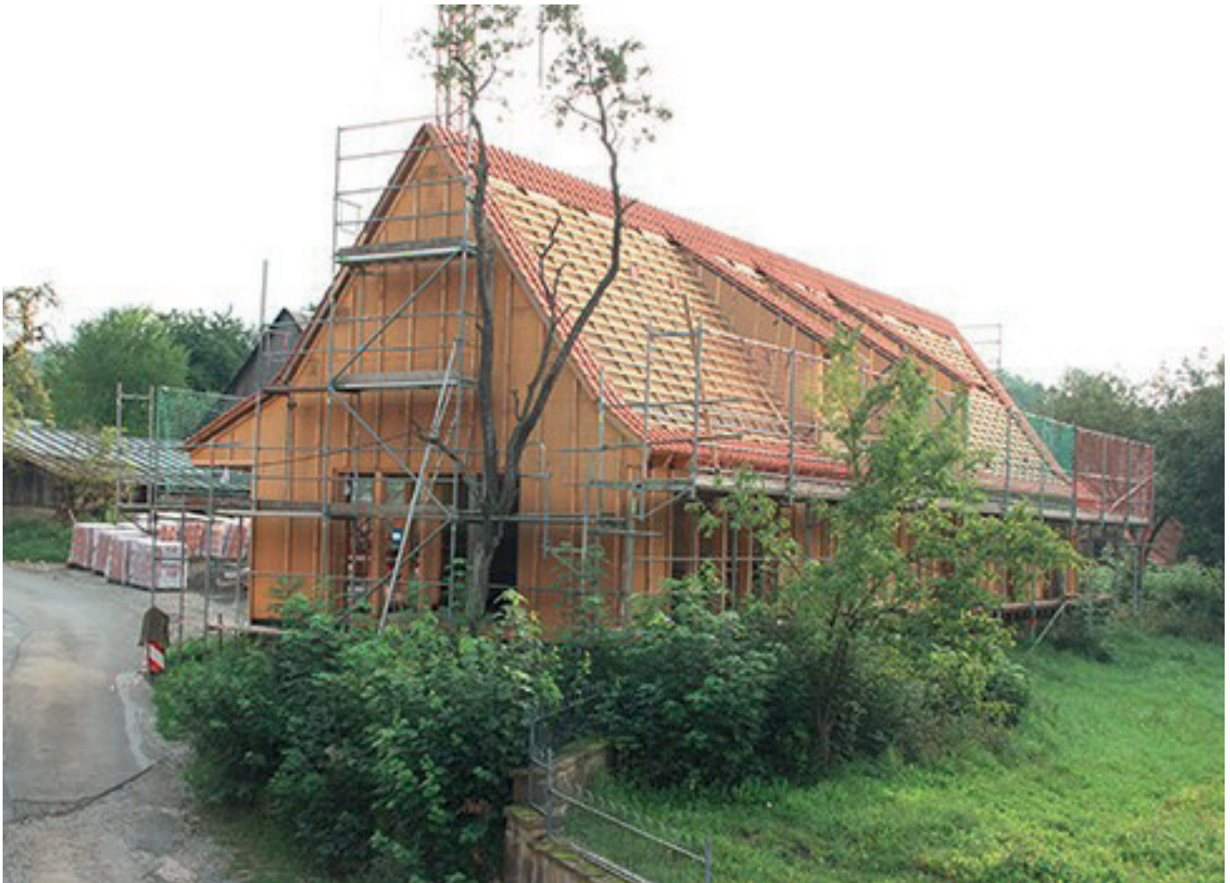
ABB. 28: Gesamtbild Wandelemente und Dachdeckung
