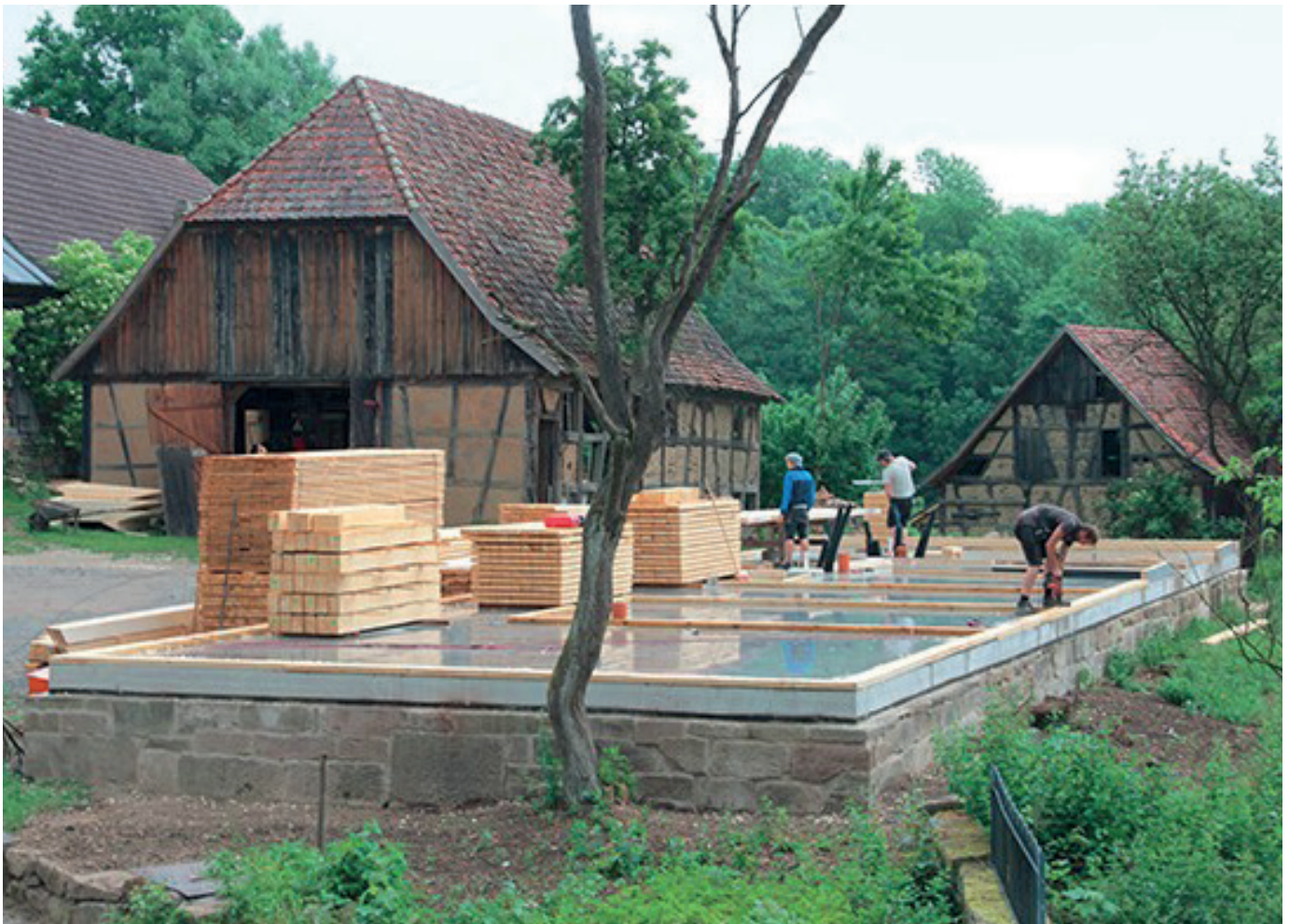
ABB. 23: Bodenplatte mit Holzschwellen
