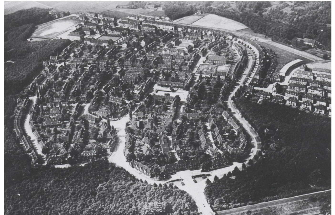
ABB. 4: Luftaufnahme der Anlage
