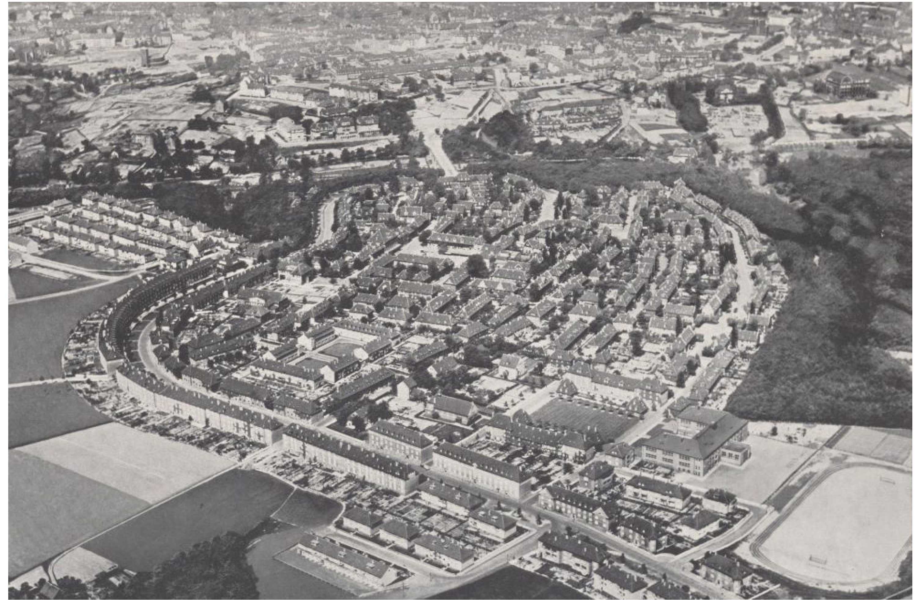
ABB. 12: Luftaufnahme der Anlage
