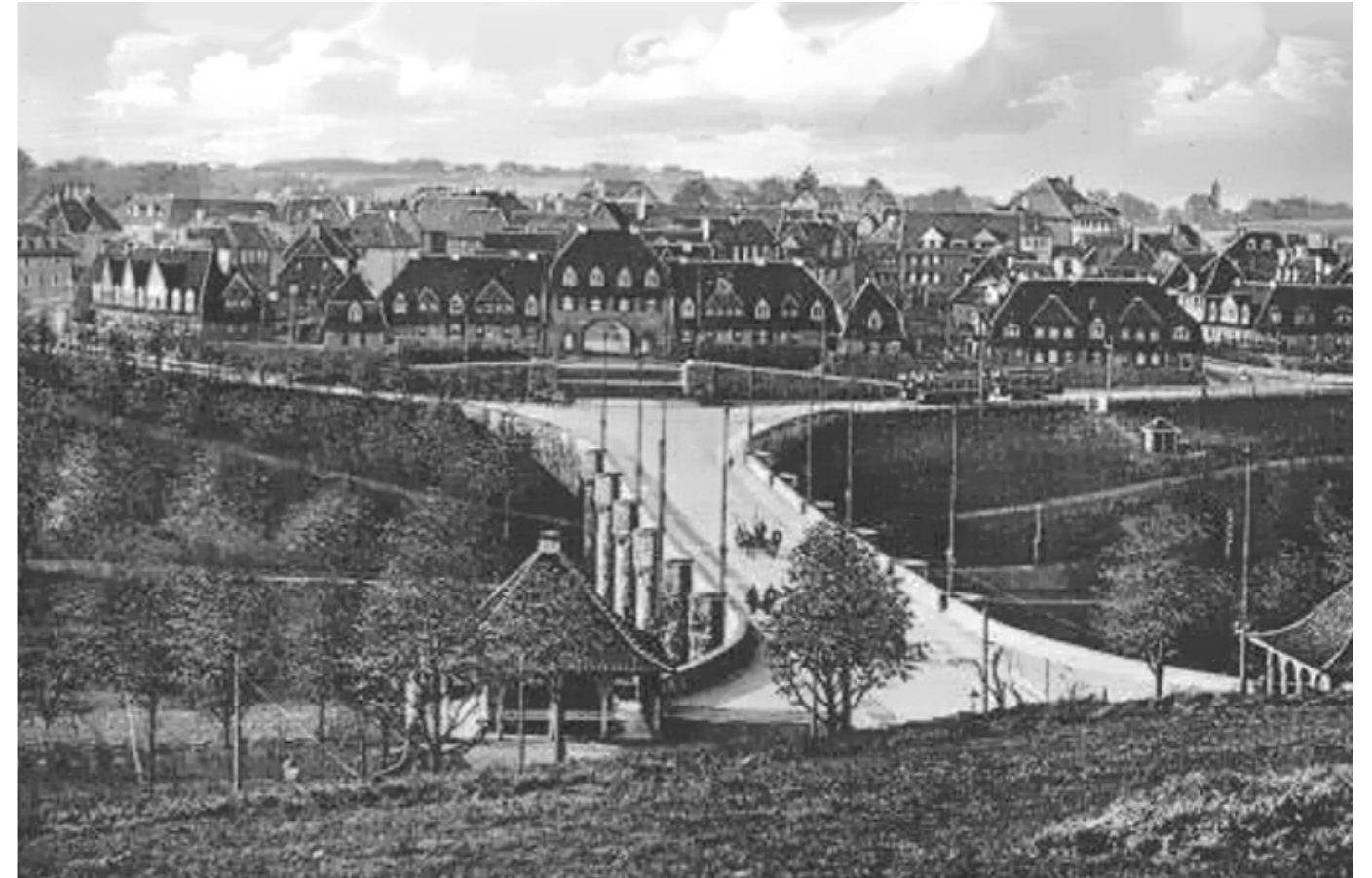
ABB. 9: Eingang der Margarethenhöhe
