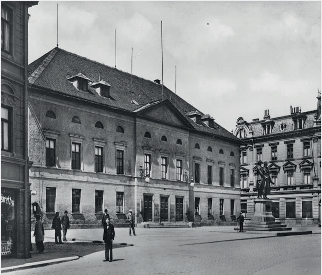
Abb. 2: Der Theaterplatz 1905 aus Süd-Ost-Richtung, links im Bild: Das dreigeschossige Geschäftshaus/ Sonntag: 109 (o. J.).
