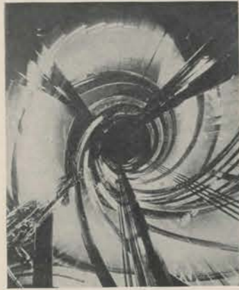
35. O. Firlé, 1928. Elevator shaft.
