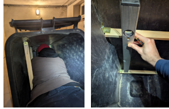
Während des Baus
