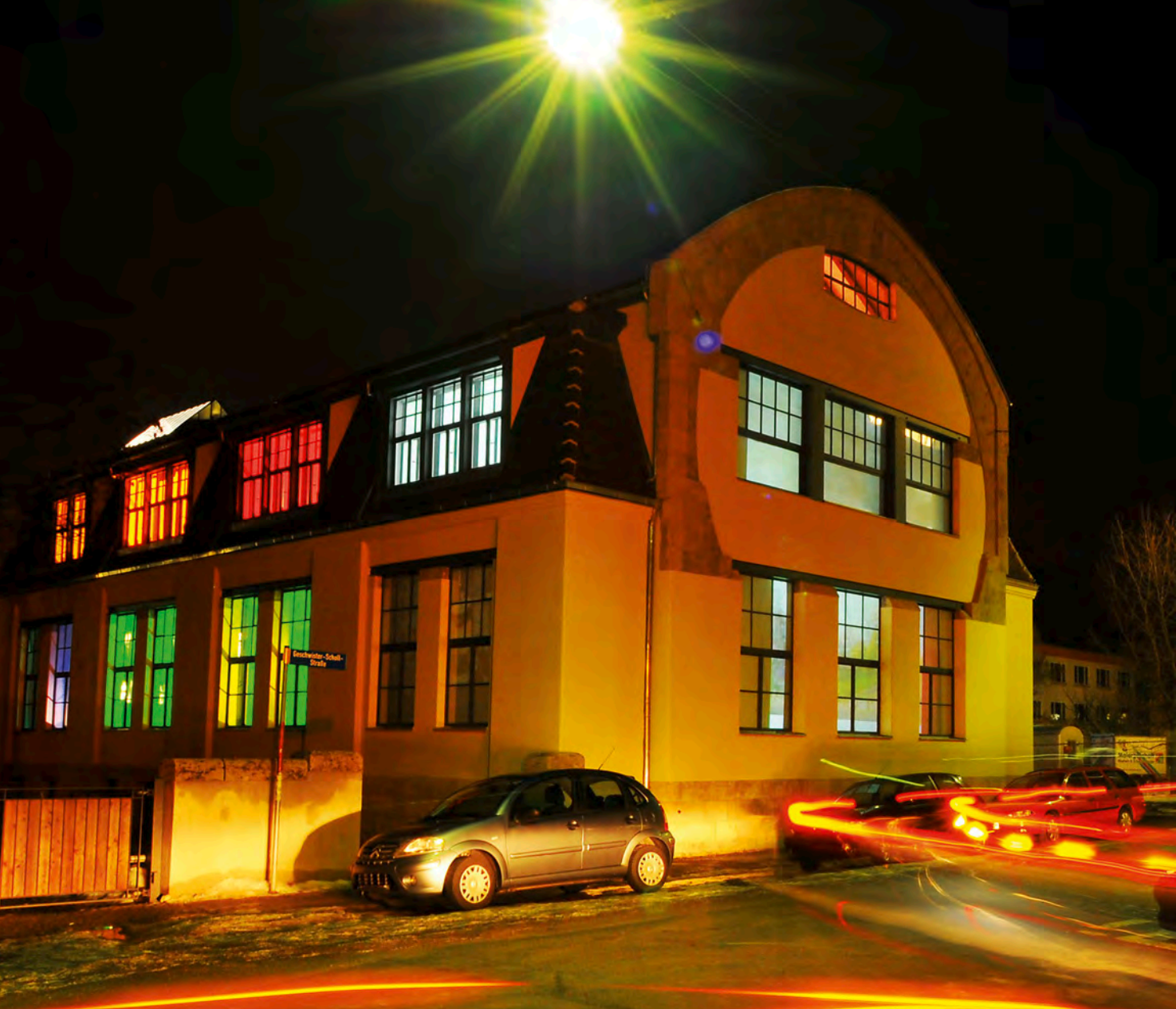
Van-de-Velde-Bau der Bauhaus-Universität Weimar mit Installation »Van-de-Velde-Laterne«.
