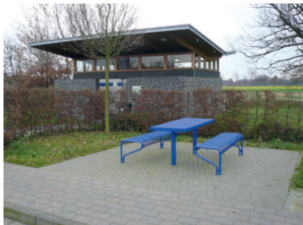
PWC-Anlage an der Autobahn. Foto: Daniel Meyer
