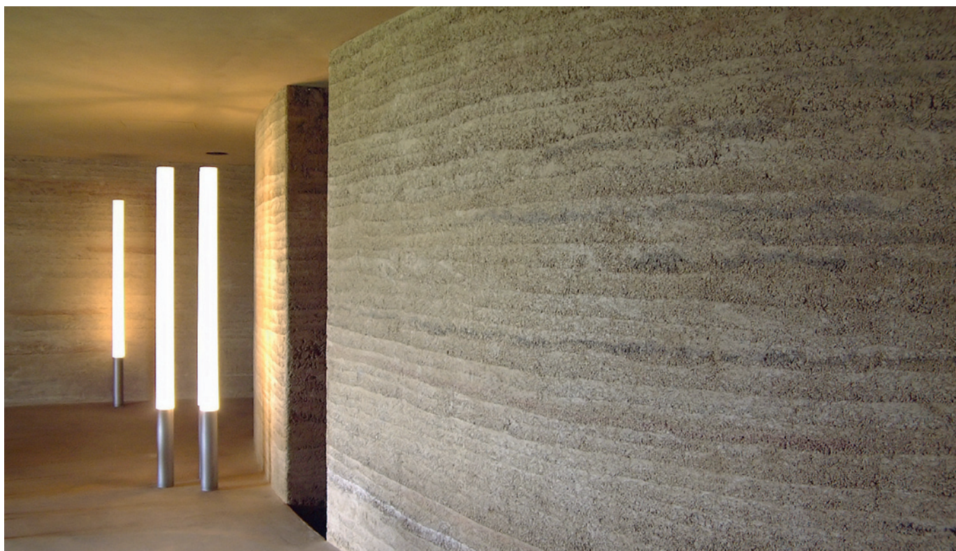
Aus Stampflehm errichtet Andachtskapelle im Zentralklinikum Suhl. Foto: Dachverband Lehm e.V.
