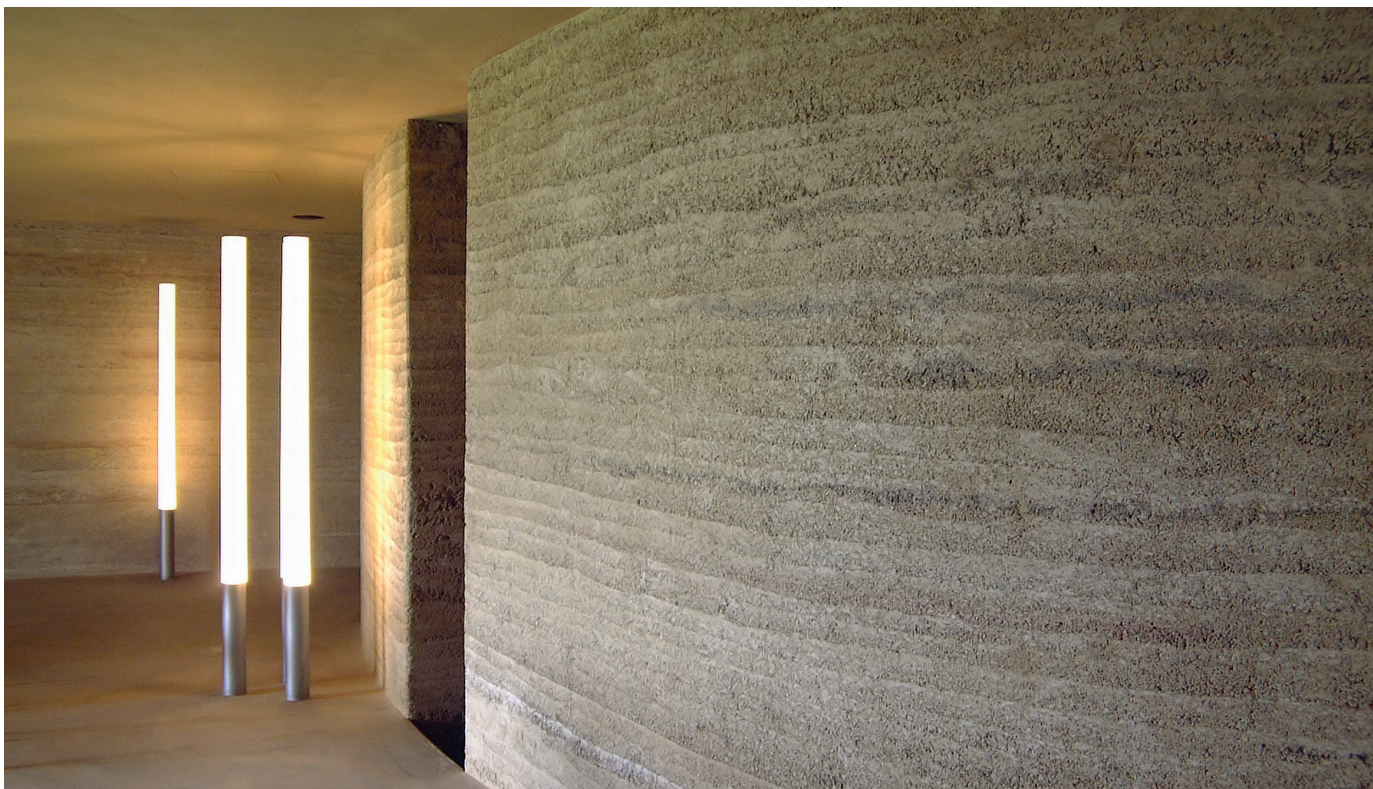
Aus Stampflehm errichtete Andachtskapelle im Zentralklinikum Suhl. Foto: Dachverband Lehm e.V.
