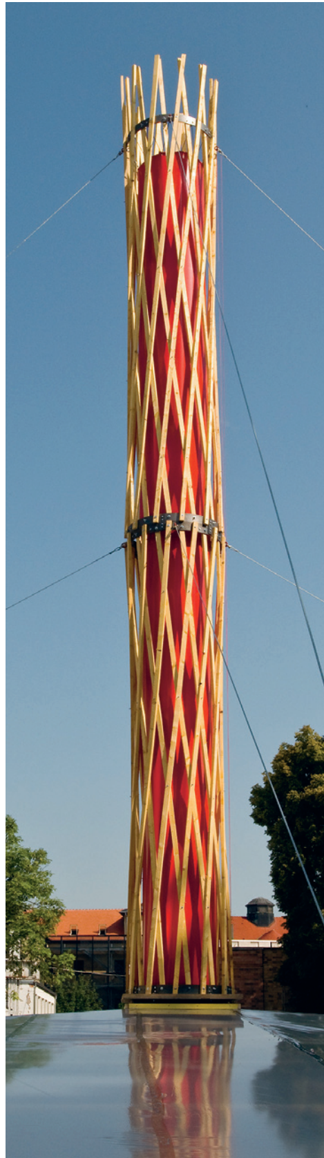
Das größte Aufwindkraftwerk Deutschlands. Foto: Tobias Adam
