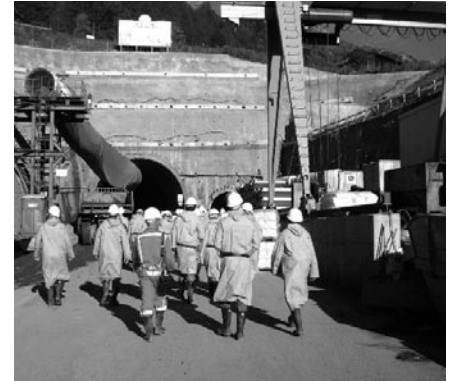
Tunnelbesichtigung Ortsumfahrung Saas. Fotos: Exkursionsbericht, Professur Verkehrsbau
