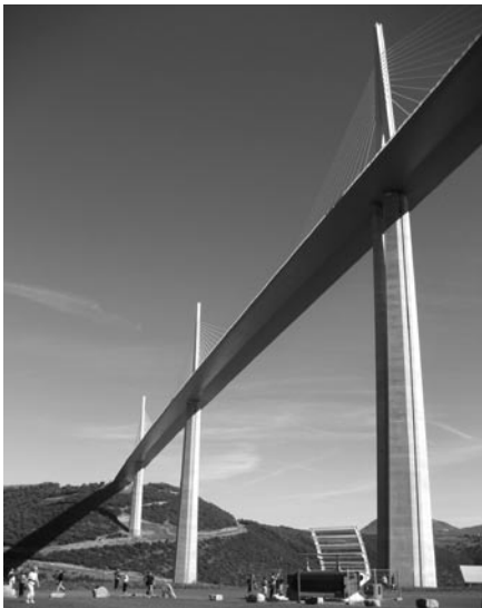
Viaduc de Millau
