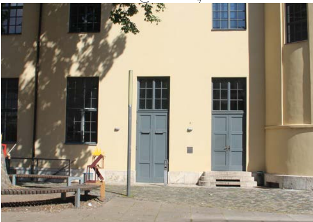
Geschwister-Scholl-Straße 8, barrierefreier Zugang Südfassade
