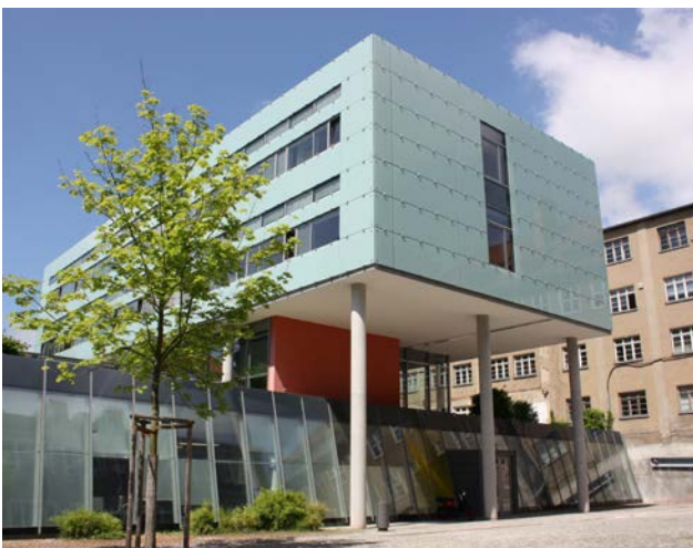
Coudraystraße 11 C, Süd-Ostfassade
