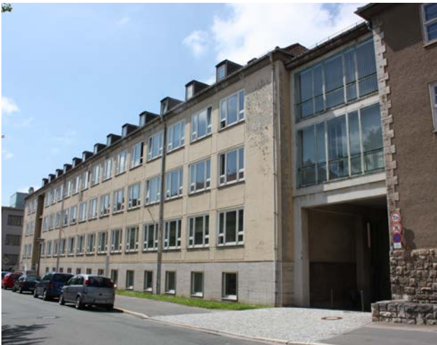
Coudraystraße 11 A, Ostfassade
