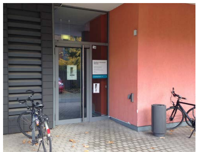
Coudraystraße 11 C, Barrierefreier Eingang
