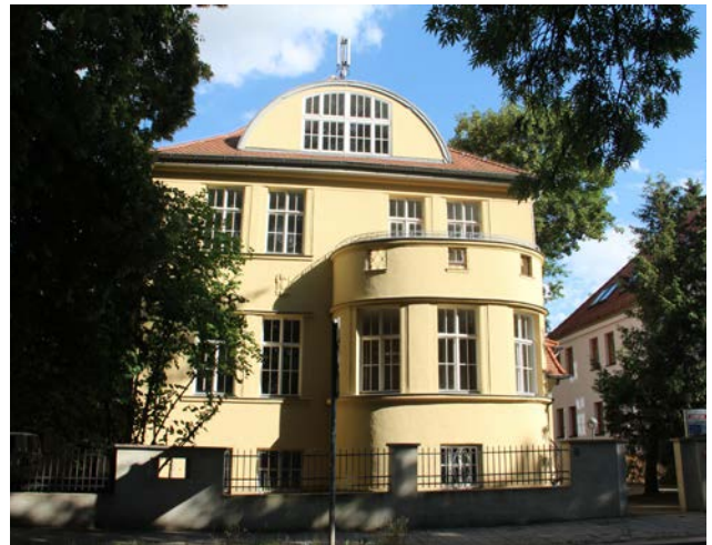
Berkaer Straße 1, Nordfassade
