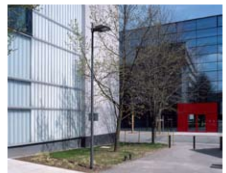
Neubau des CIB in der Coudraystraße, Foto: Tobias
