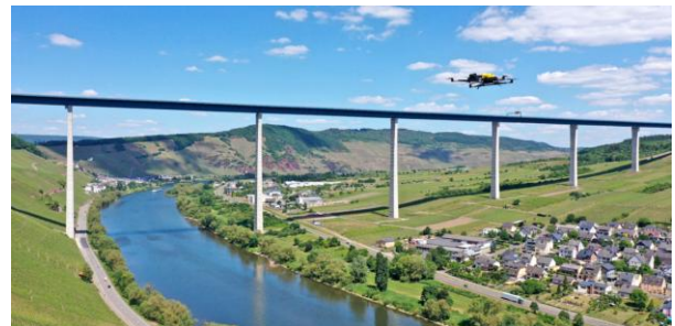
Bildbasierte Erfassung der Hochmoselbrücke (Zeltingen-Rachtig, Rheinland-Pfalz), Foto: N. Hallermann
