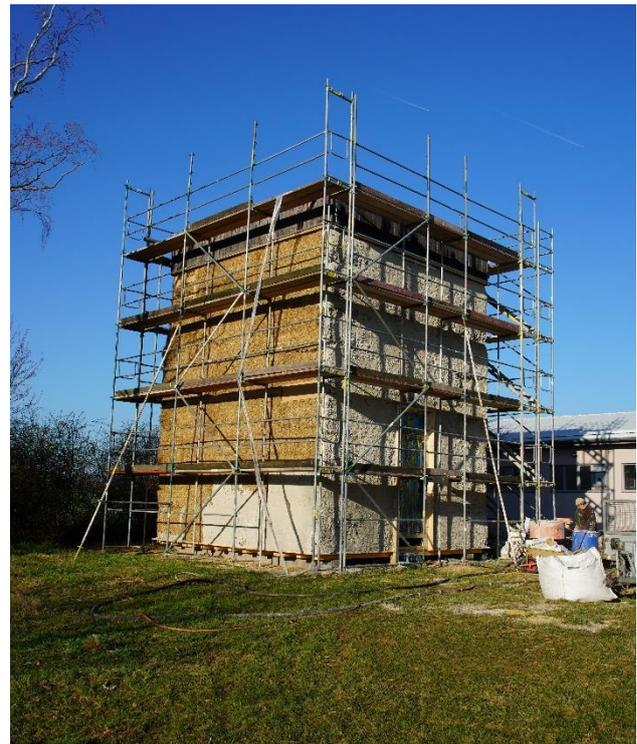
Demonstratorgebäude in lasttragender Strohballenbauweise während der Errichtung (Foto: MSK)
