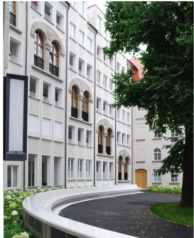
Mit der Wiederverwendung von Bauteilen (hier: Wohnüberbauung am Kloostergarten, München-Lehel, Hild & K, 2009) wird eine partielle Ähnlichkeit mit dem Vorgängerbau erzeugt. Sucht man damit die Dignität des Alters, Tradition zu bewahren oder an das Zerstörte zu erinnern? (Foto: Thomas Will, Dresden)
