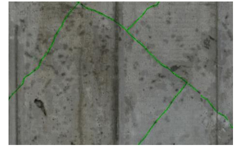
Beschädigungen / Risse (ML)
