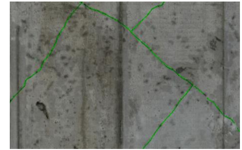
Beschädigungen / Risse (ML)
