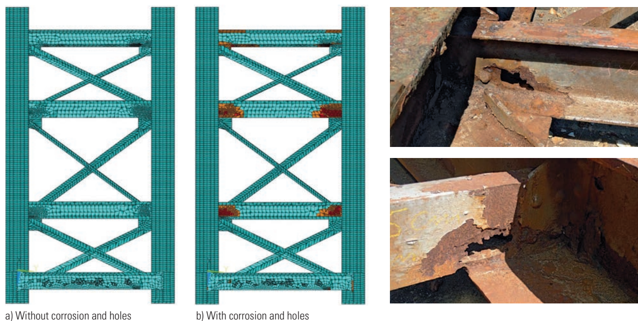
Fig. 3. Left: FE model of the bridge, right: corrosion and holes in cross girders Bild 3. Links: FE-Modell der Brücke, rechts: Korrosion und Löcher in Querträger
