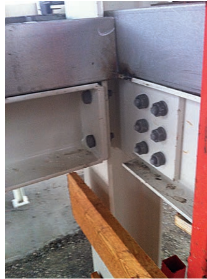
Bild 3. „Gelenkiger“ Deckenträgeranschluss Fig. 3. Hinged floor beam connection
