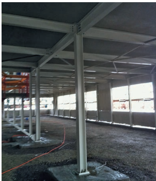
Bild 2. „Gelenkiger“ Stützenfußpunkt Fig. 2. „Hinged“ base of the column
