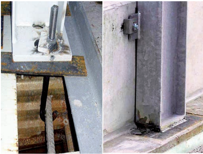
Bild 1. Praktische Ausführungen von Stützenverankerungen Fig. 1. Practical examples of column fixings
