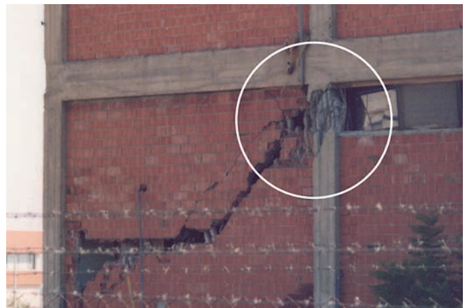
Bild 1. Stark geschädigte Stütze infolge der rotationsbehindernden Wirkung der Ausfachung (short column effect)
