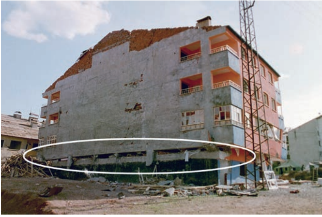
Bild 2. Totalversagen des 1. Obergeschosses (Stockwerkmechanismus)
