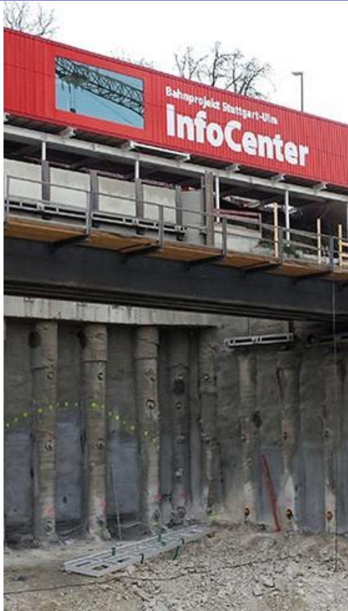
6. Station am 03. Juni 2016 Bahnprojekt Stuttgart - Ulm
