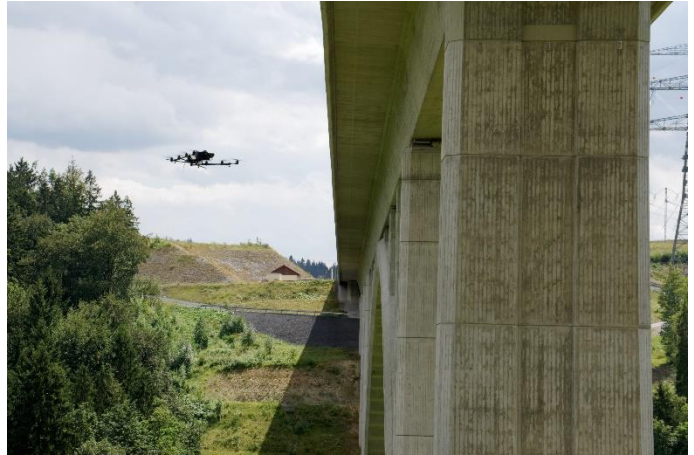
Ein unbemanntes Flugsystem (UAS) im Einsatz an einer Brücke. (Quelle: Bauhaus-Universität Weimar, Norman Hallermann)
