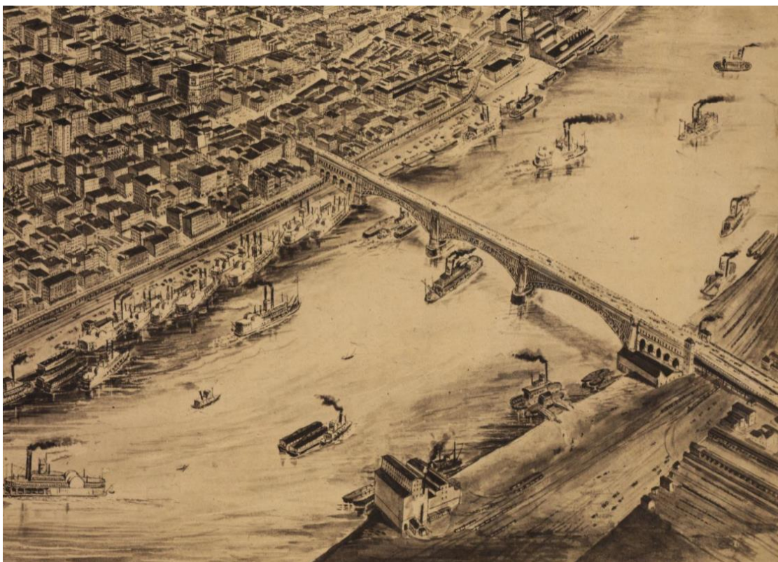
Bild Wikipedia: Eads Bridge über den Mississippi in St.Louis (Missouri)
