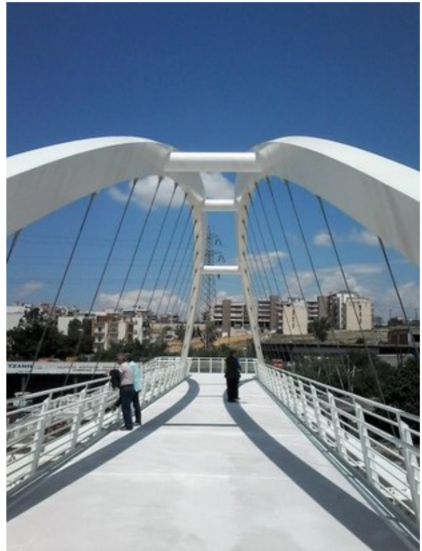
Die Fußgängerbrücke in Thessaloniki dient als Referenzobjekt für das Forschungsprojekt. (Foto: Kosmas Dragos) Download-Version
