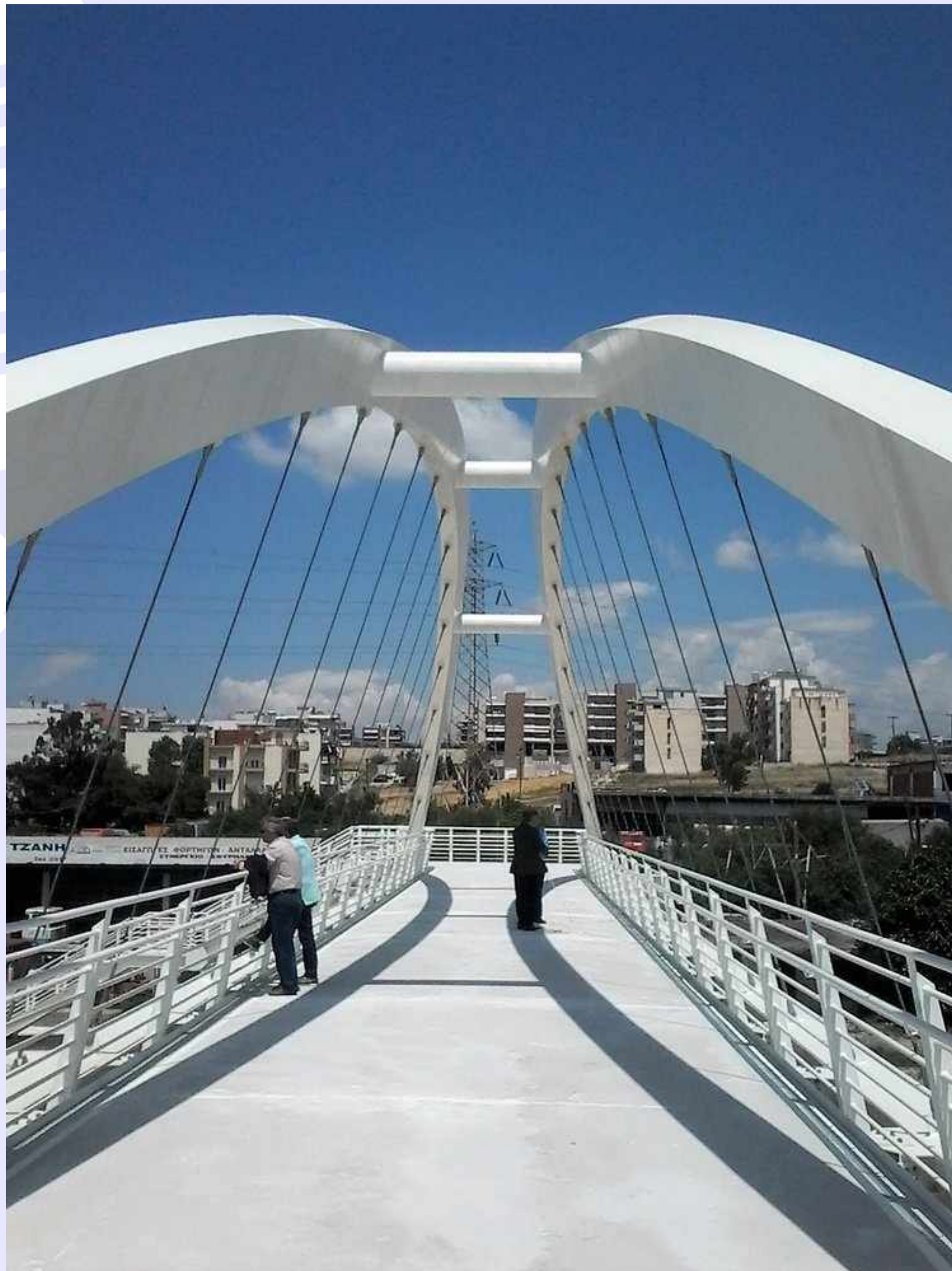
Die Fußgängerbrücke in Thessaloniki dient als Referenzobjekt für das Forschungsprojekt., Foto: Kosmas Dragos
