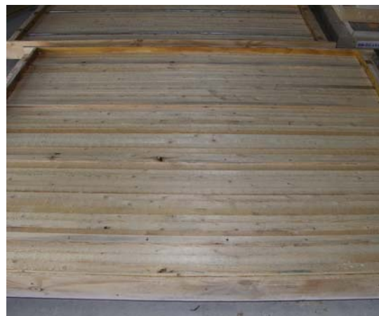
Wandelement als Brettstapelement
