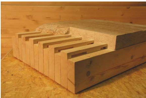
Abb. 80 Massivholz-Hybriddecke mit Detail Flächenverbund
