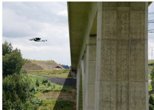
Ein unbemanntes Flugsystem (UAS) im Einsatz an einer Brücke. (Quelle: Bauhaus-Universität Weimar, Norman Hallermann)
