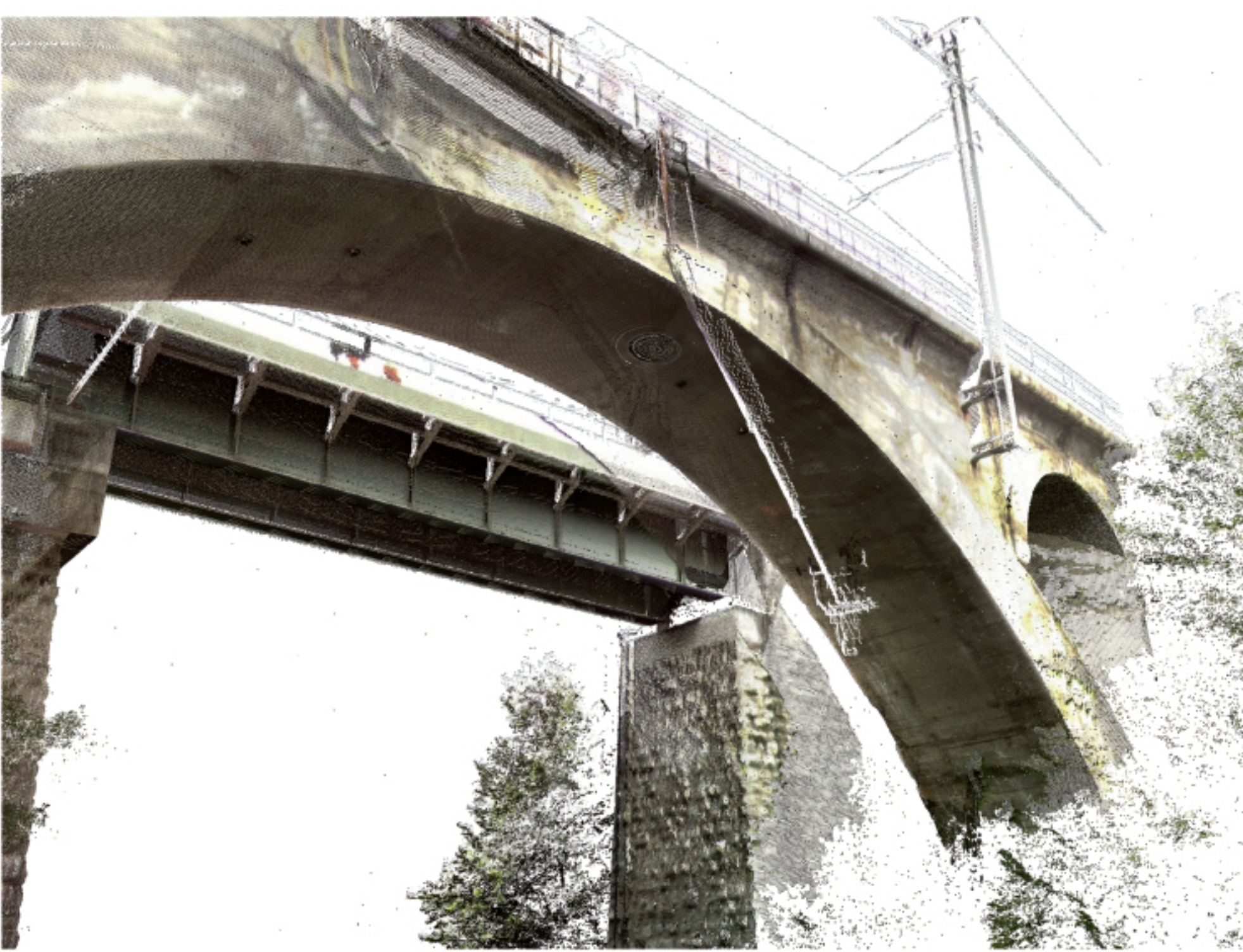
Abb. 4: Scan einer Stahlbetongewölbebrücke
