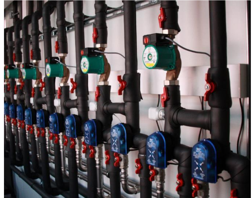
Verteiler für Heizung / Kälte der bestehenden Klimakammer
