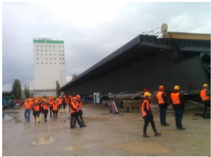
Brückenbauteil für die Schiersteiner Brücke
