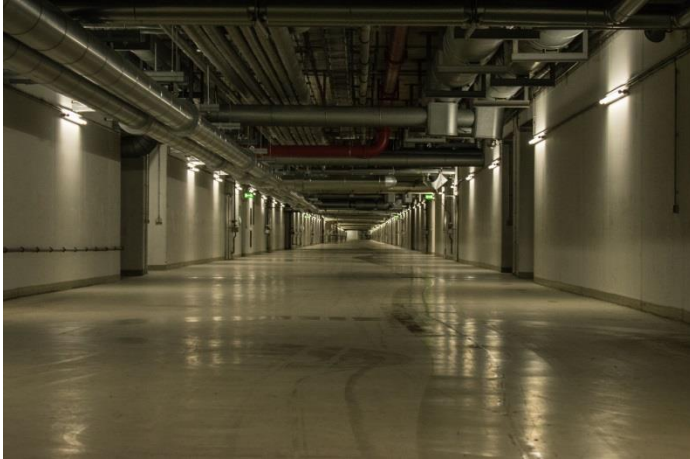
Untergeschoss eines Flughafenterminals in Frankfurt
