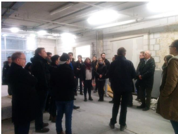
Baustelle im Shopping Center Lilien-Carré
