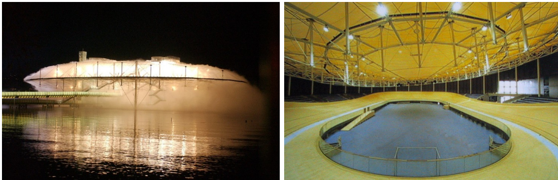
Abb. 6.2: Nach dem Tensegrity-Konzept realisierte Seil-Stab-Systeme, links: „Die Wolke“ in Yverdon-les-Bains; rechts: Velodrom in Aigle; (Fotos: Airlight Ltd.)
