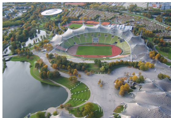
Abb. 1.4: Olympiastadion in München; erdverankertes Seiltragwerk
