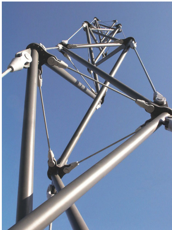
Abb. 6.1: Messeturm in Rostock, im Tensegrity-Zustand befindlicher Seil-Stab-Turm mit Druckstabkontakt; (Foto: MERO-TSK)
