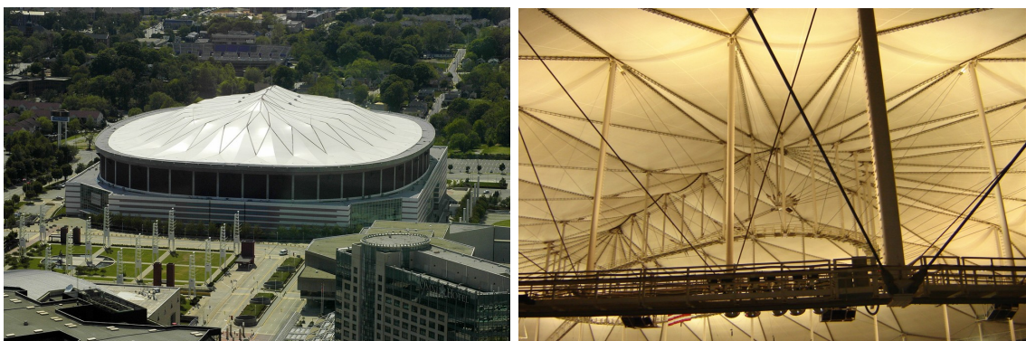
Abb. 1.5: Georgia Dome in Atlanta; über eine massive Subkonstruktion verankertes Seiltragwerk, links: Außenansicht; rechts: Innenansicht
