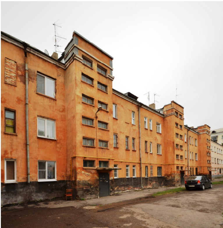
Abb. 3 Wohngebäude über winkelförmigem Grundriss, Arch. Johann Niegemann, err. um 1934 (Foto: Professur Denkmalpflege und Baugeschichte BUW)
