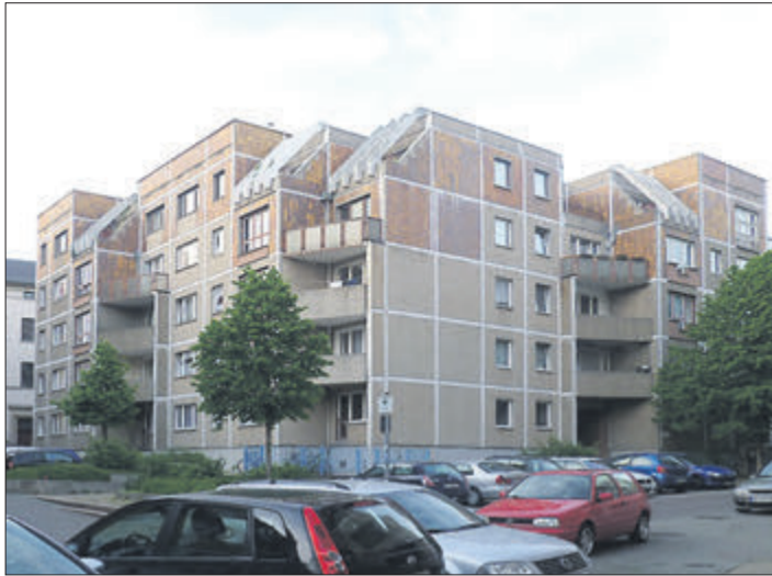
„Das wertvolle Alte mit dem selbstbewussten Neuen verbinden“ wollten die Planer der halleschen Innenstadt-Neubauten in den 1980er Jahren. Die Ergebnisse waren beispielgebend für die ganze DDR. Foto: Barbara Mann
