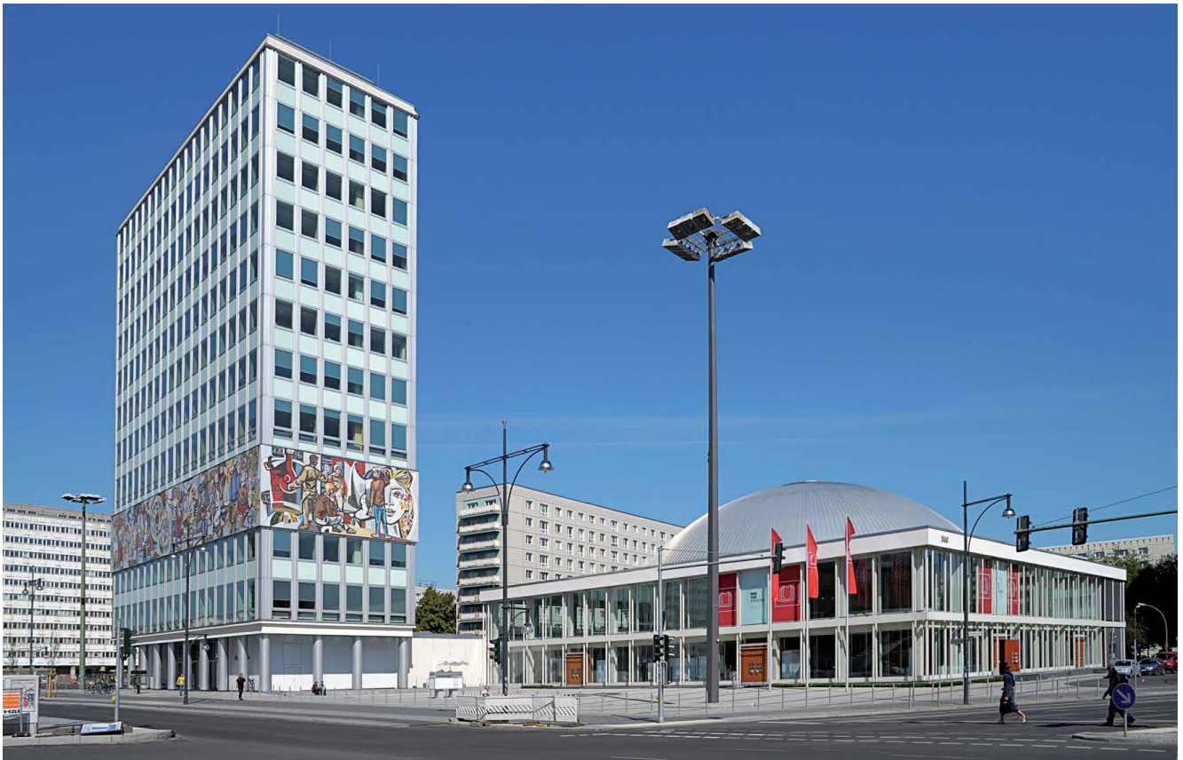
Berlin, Haus des Lehrers und Kongresshalle von Hermann Henselmann (1961–1964), nach der Sanierung (Foto: Wolfgang Bittner, Berlin)
