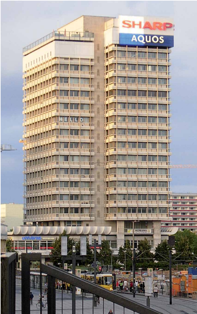
Neben der Alltagsarchitektur ist sogar die individuelle Architektur der DDR oft vom Abriss bedroht: das Berliner Haus des Reisens von Roland Korn und Johannes Brieske aus dem Jahr 1971
