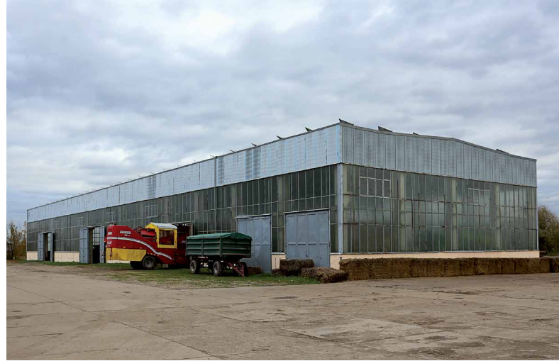
»EMZG« mit Betonskelett einer ehemaligen LPG in Sadenbeck
